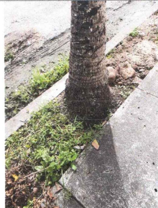
Foto 4. Vista frontal de la palma de coco donde se puede apreciar el levantamiento de la banqueta peatonal por las raíces.
